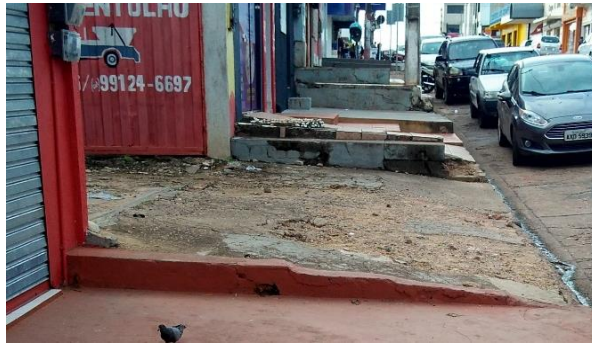
Figura 1 – Ausência de acessibilidade na Avenida Nagib Mutran.
